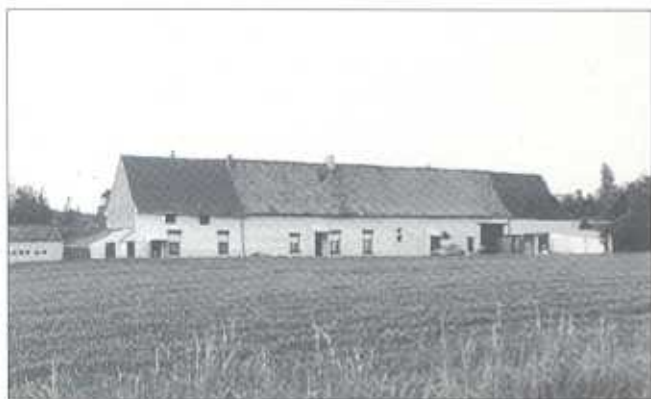
De voormalige stallingleugel omgebouwd tot woningen.
